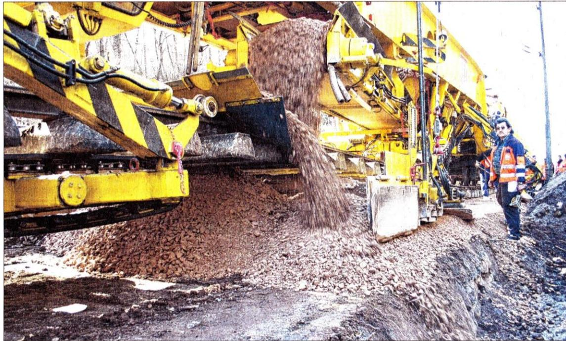
Im Schnecken-tempo bewegt sich die Baumaschine über die Schienen. Sie hebt den Gleisrost an und baut auf knapp vier Kilometern Länge ein 30 Zentimeter dickes Schotter-Sand-Gemisch als Schutzschicht ein. Fotos: Dürr
