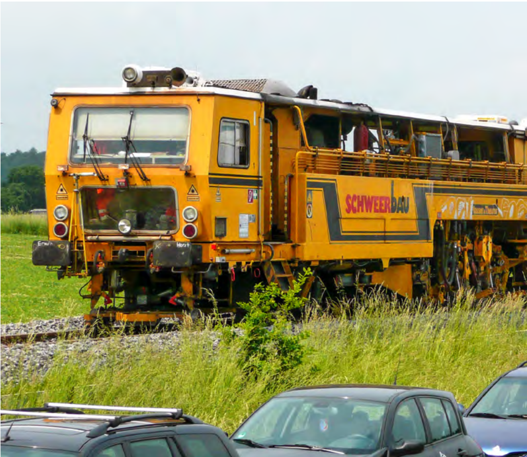
Zwei Stopfmaschinen verdichteten am 6.6.08 in Neuendettelsau bei der Firma Sellner das Gleisbett.
