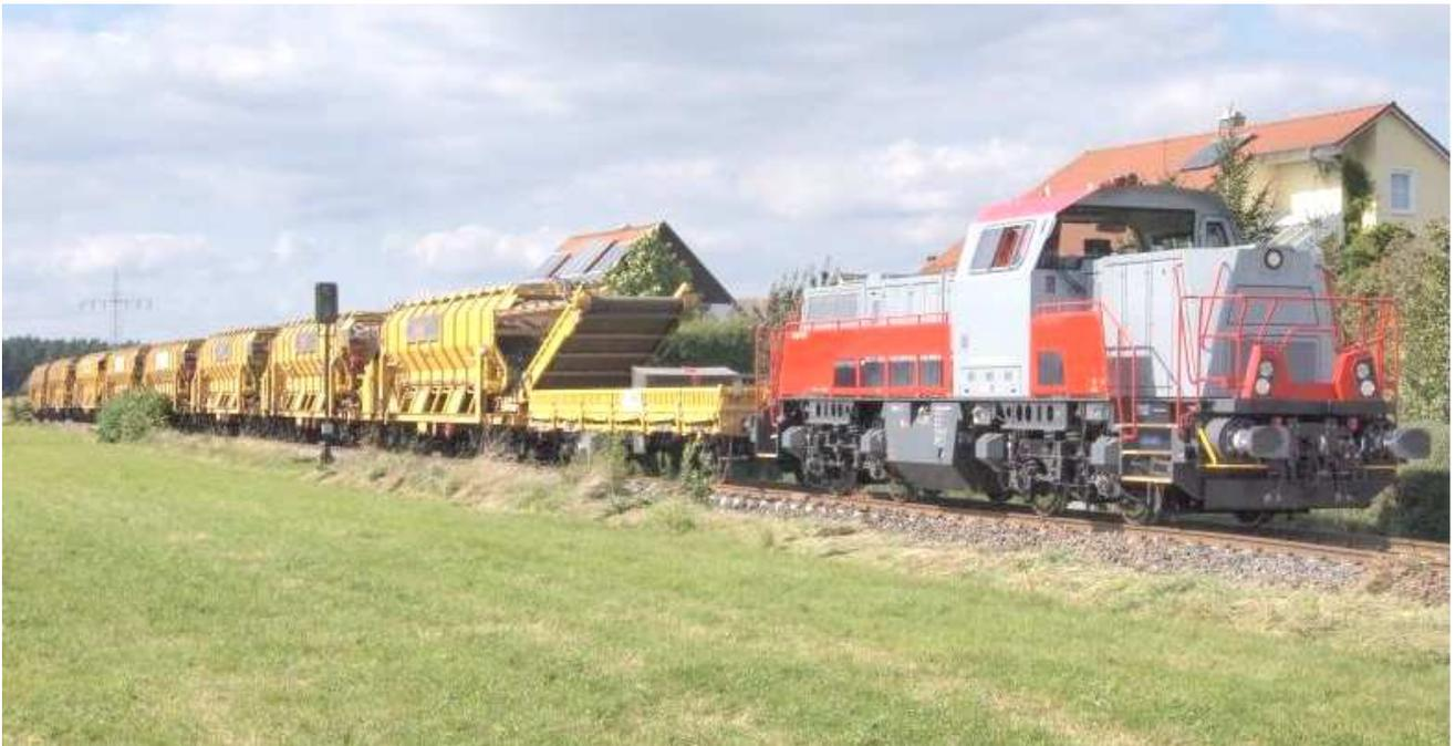
Am 31.8.14 regnete es den ganzen Tag, und die ausgesiebte Erde wurde noch dunkler und klumpiger. Der Reinigungszug war dennoch ständig in 2 oder 3 Teilen unterwegs und hatte bis zum Abend die ganzen 2,5 km durchgearbeitet. Die Schotterberge bei km 3,0 wuchsen entsprechend rasch an.
