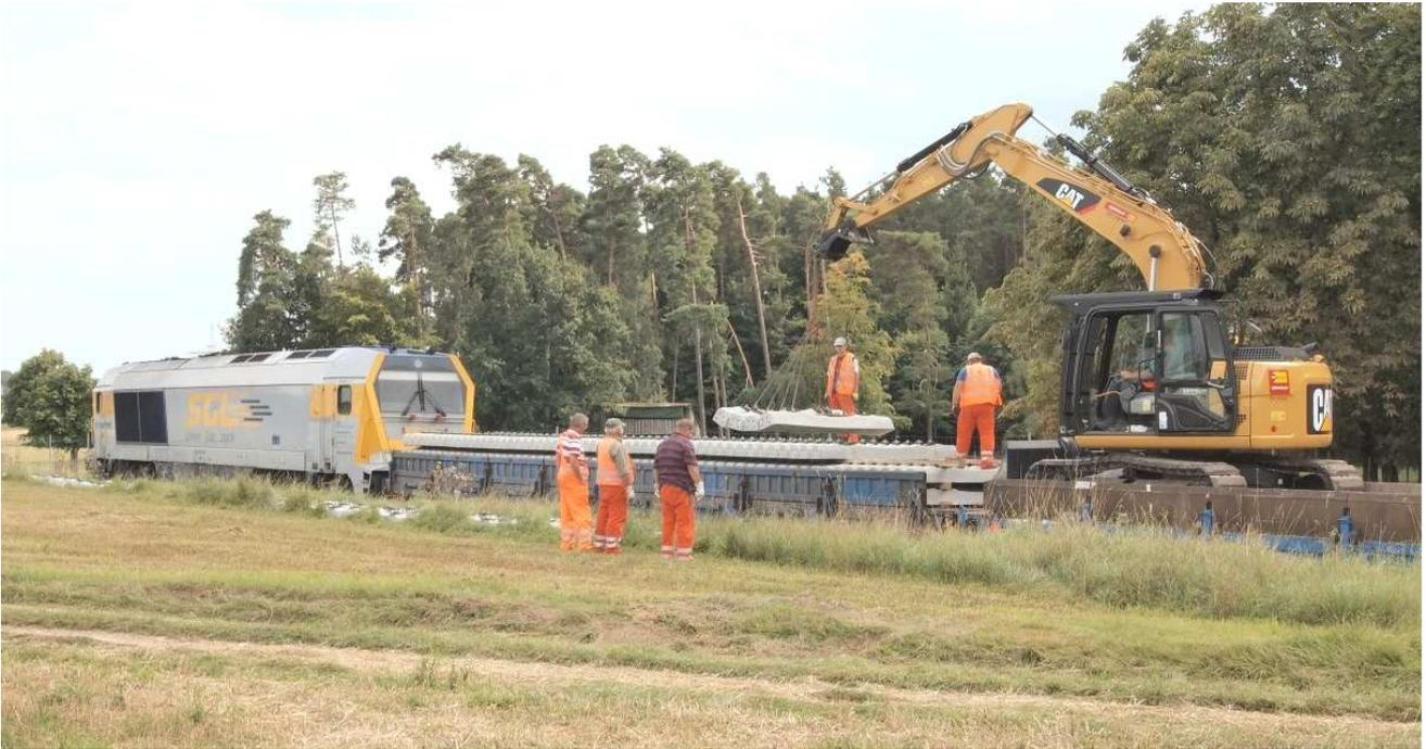
Gegen 16.30 Uhr wurden die letzten Schwellen beim Tennisplatz (km 1,5) abgeladen. Dann fuhr der Zug zum Haltepunkt Petersaurach zurück und entlud westlich vom Bahnsteig das Holz und die Kleinteile, mit denen die Schwellen auf den Flachwagen gesichert waren. (*Oben bei km 2 und links im Haltepunkt Petersaurach.*)
