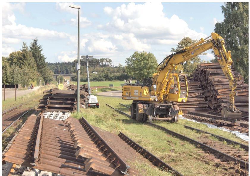
Gegen 16 Uhr hatte der Gleisabbau Strecken-km 1,5 beim Tennisplatz erreicht. Da sich die 2WB auf dem Gleis nicht „überholen“ konnten, legte der nördlichere 2WB die Gleisfelder an verschiedenen Stellen ab, wo sie der südlichere 2WB aufnahm und zum Lagerplatz in km 2,9 brachte. Dort wurden Schienen, Stahl- und Betonschwellen getrennt und auf drei Plätzen gestapelt.
