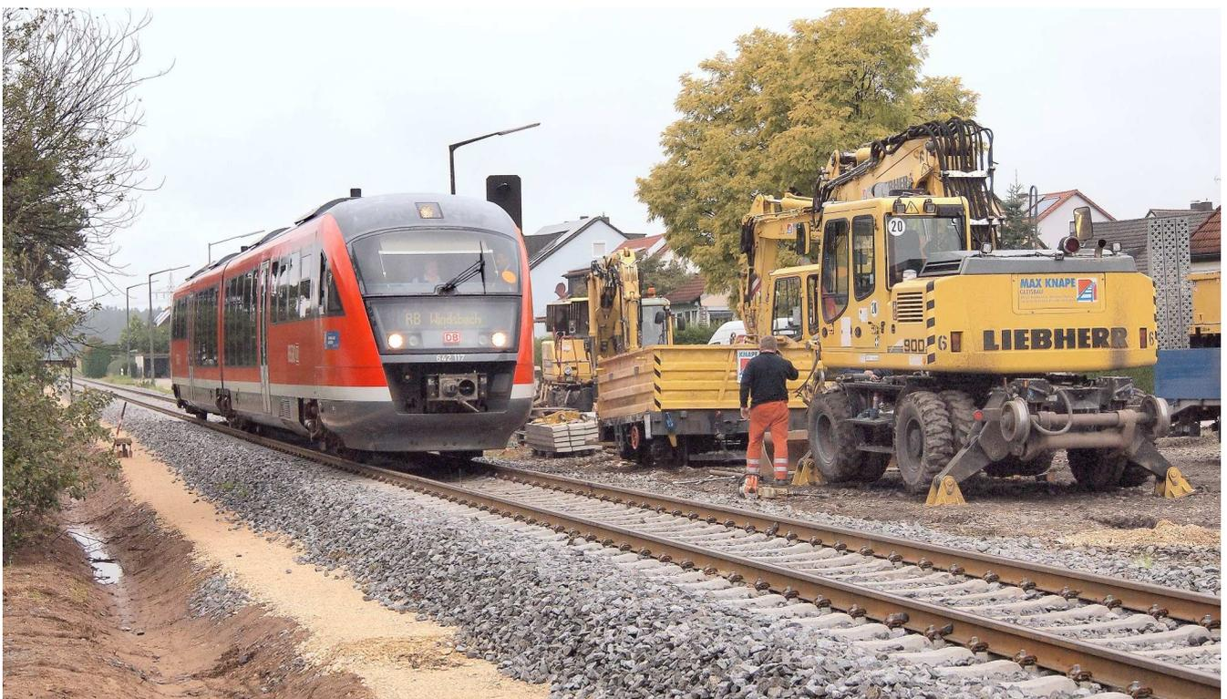
Die Bauarbeiten gingen nämlich weiter, teilweise tagsüber neben dem Gleis und teilweise nachts während der Streckenperrung von ca. 22 bis 4.30 Uhr. Das war schon vorher für mindestens eine Woche geplant worden, um den Randwegebau abzuschließen und die angepachteten Flächen wieder in den ursprünglichen Zustand zu bringen.
